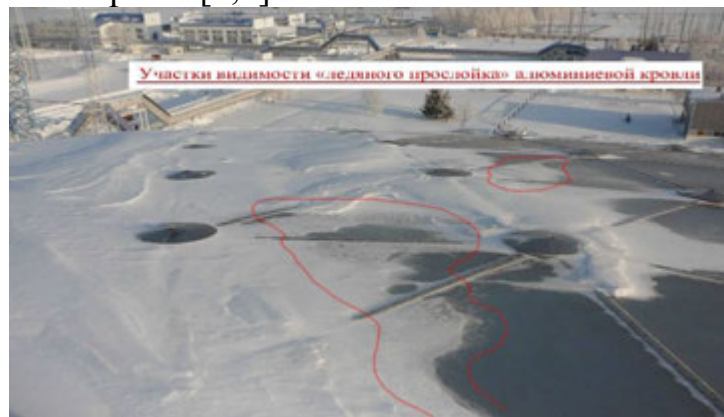
Рисунок 6. Граничный слой – «ледяная прослойка» на алюминиевой кровле
