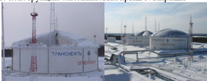
Рисунок 4. Разрушение конструкции алюминиевой крыши п. Талакан
